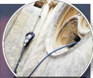
Die Sensoren sind 20 Meter über der Türmerstube (70 Meter hoch) montiert.
